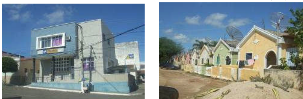
FIGURA 40. Prédio Atual da sede do Correio (à direita) e Vila da Mina Brejuí (à esquerda)
