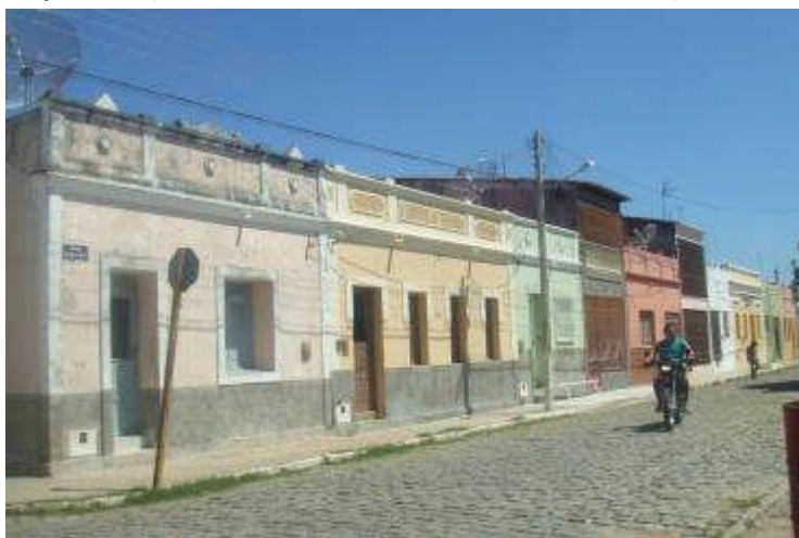
FIGURA 14. Edificações Implantadas no Limite do Lote – Município de São João do Sabugi
