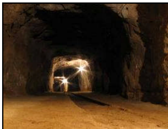
FIGURA 77. Interior de Galeria Mina Brejuí, Currais Novos.
