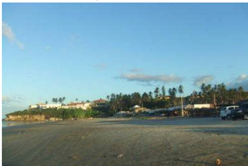
FIGURA 04. Edificações Construídas na Área de APP.
