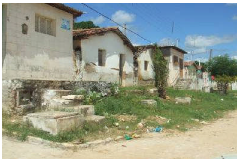
FIGURA 05. Edificações Construídas Desrespeitando a Topografia Local – Município de Pendências.
