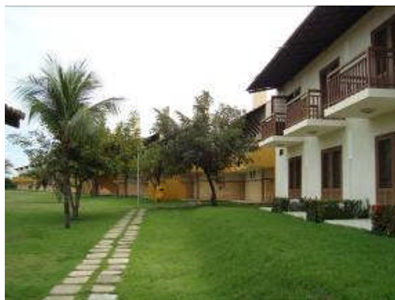
FIGURA 74. Meio de Hospedagem no Polo Costa Branca
