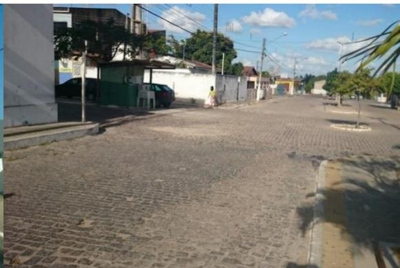
**FOTO 32: VIA CALÇADA COM PARALELEPÍPEDOS QUE JUNTAMENTE COM O MEIO FIO É RESPONSÁVEL PELA COLETA E CONDUÇÃO DAS ÁGUAS PLUVIAIS NA CIDADE DE PASSA E FICA.**
