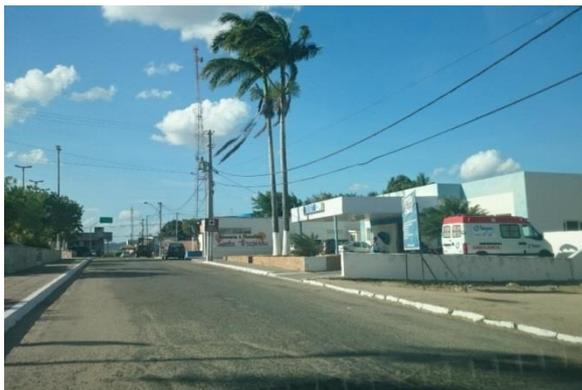
**FOTO 31: VIA ASFALTADA E MEIO FIO EM AMBOS OS LADOS QUE FUNCIONA COMO COLETOR DE ÁGUAS PLUVIAIS NA CIDADE DE TANGARÁ.**
