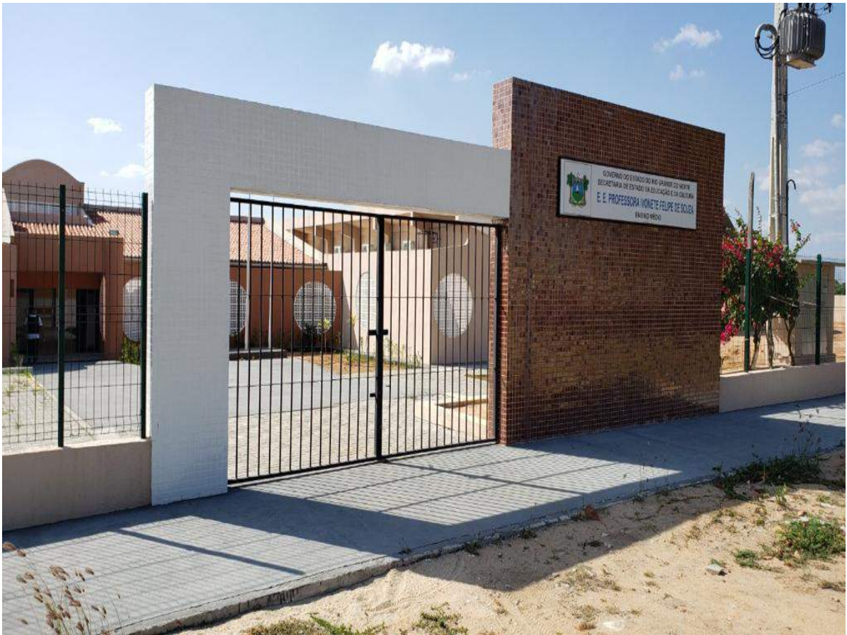
Construção da Escola Estadual Ivonete Felipe de Souza em Macaíba/RN
