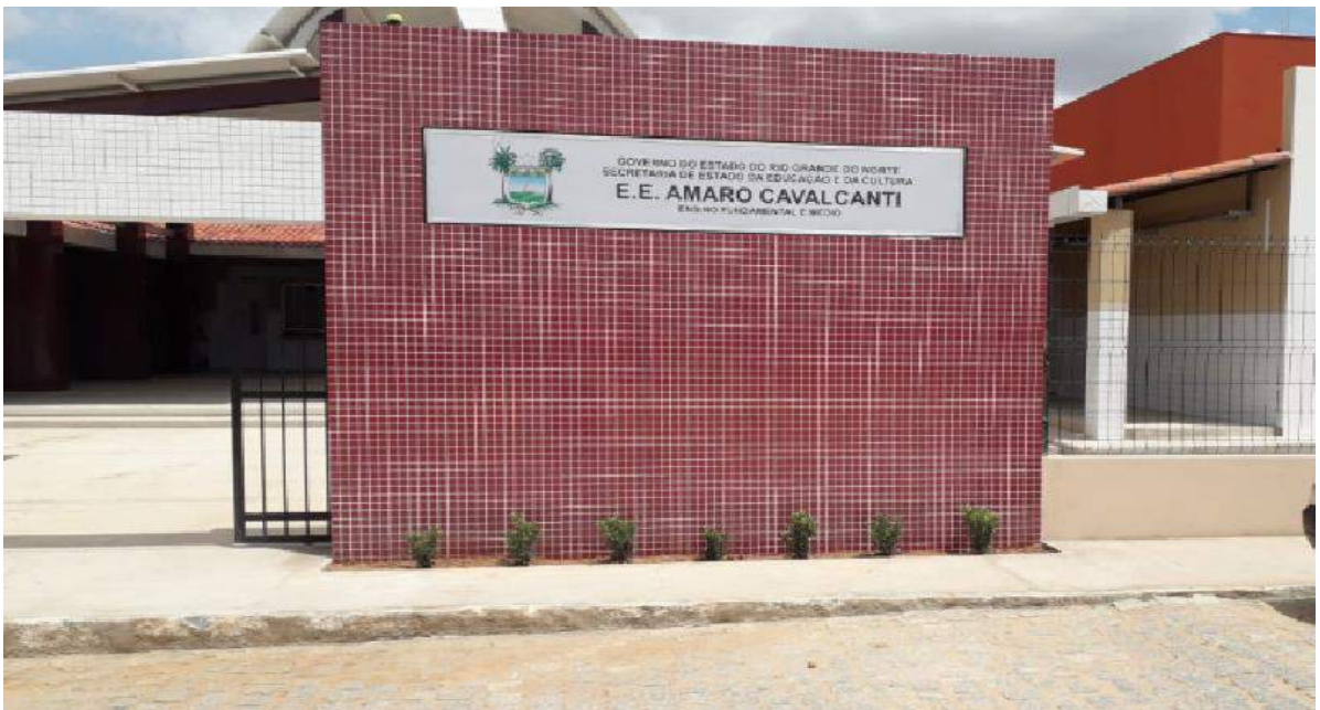
Reforma da Escola Estadual Amaro Cavalcanti em Jardim de Piranhas/RN.
