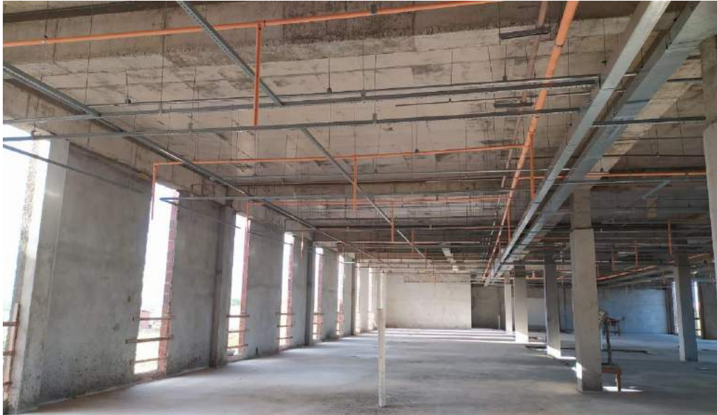
Foto 5 – Bloco A - Alvenaria - Instalações – Contrapiso – Reboco
