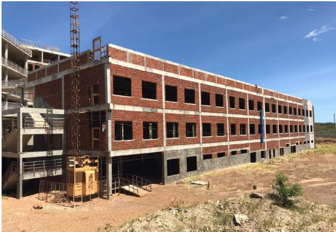
Foto 9 – Fachada do Bloco “A”
