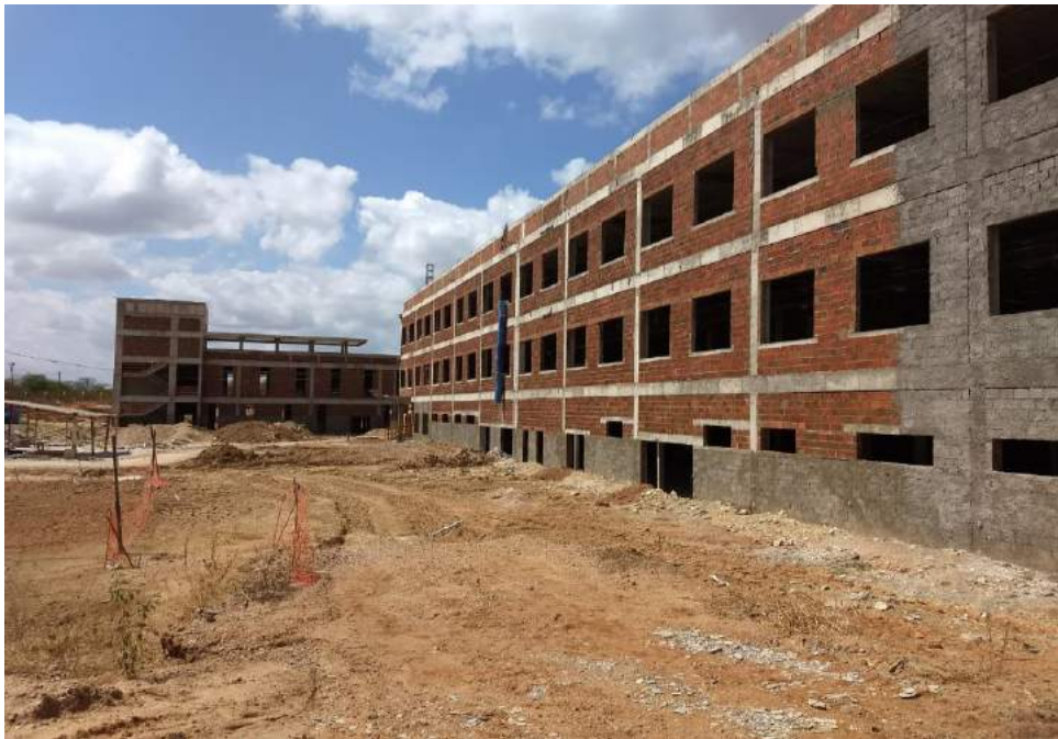
Foto 2 – Fachadas do Bloco “A” e “D”
