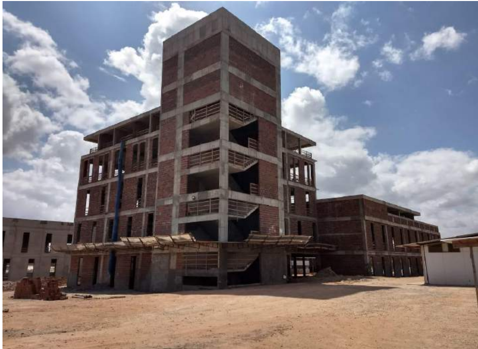
Foto 1 – Fachadas do Bloco “A”, “B” e “C”
