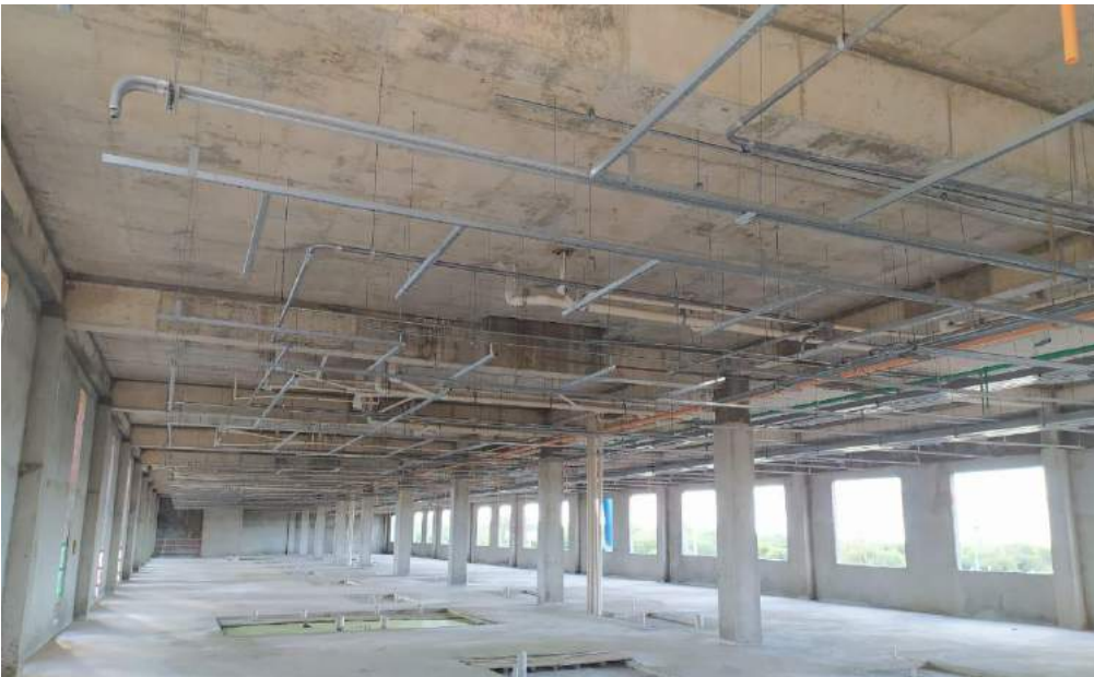
Foto 4 – Bloco A - Alvenaria - Instalações – Contrapiso – Reboco
