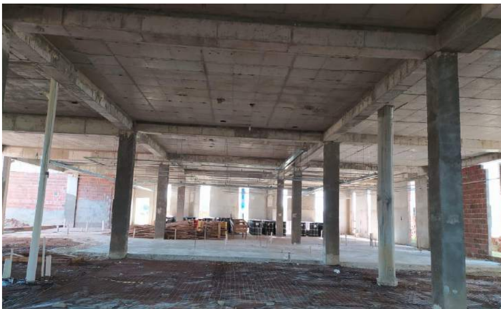
Foto 8 – Contrapiso parcialmente executado no Bloco “C”
