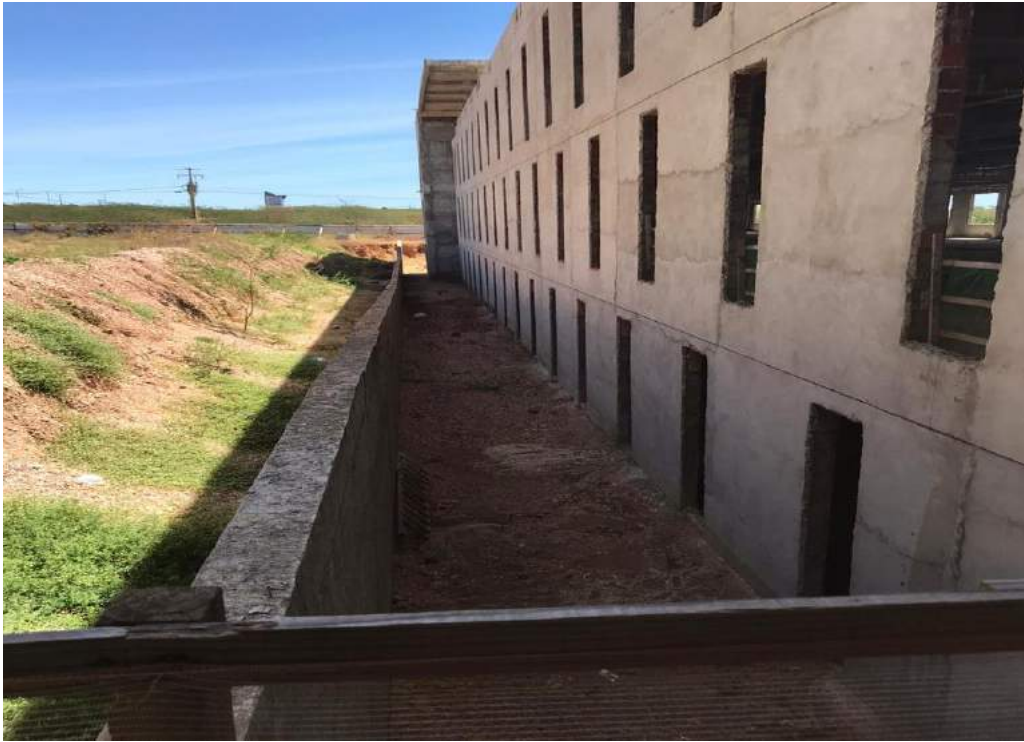
Foto 11 – Muro de contenção e Fachada do Bloco “A” revestido.
