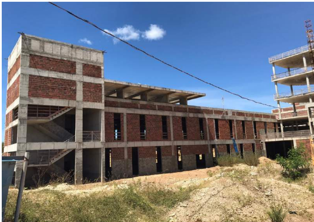
Foto 10 – Fachada do Bloco “B” e “C”
