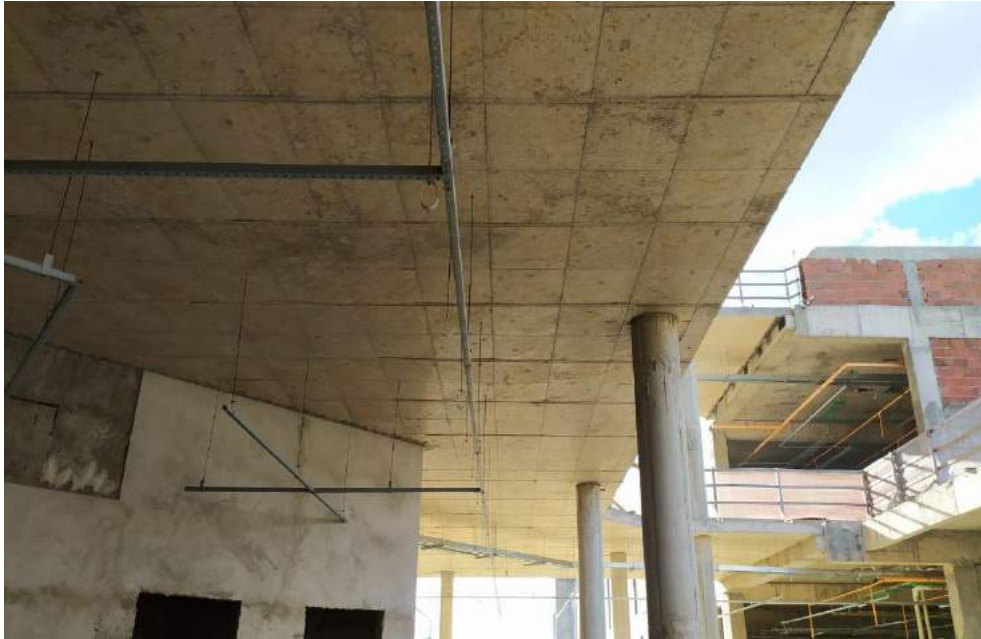
Foto 7 – Vista dos Blocos “B” e ‘C”
