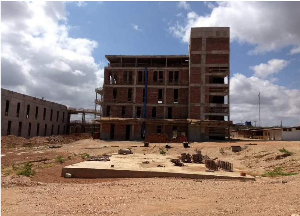
Foto 12 – Reservatório inferior e fachada dos Blocos “A” e “C”
