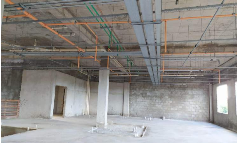
Foto 3 – Bloco A - Alvenaria - Instalações – Contrapiso – Reboco
