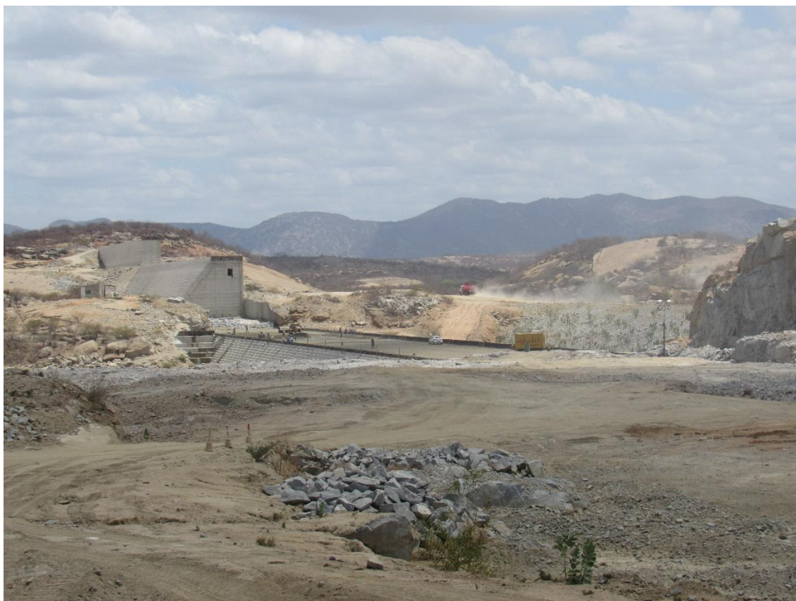
Figura 1.8 – Obras do reservatório de Oiticica
