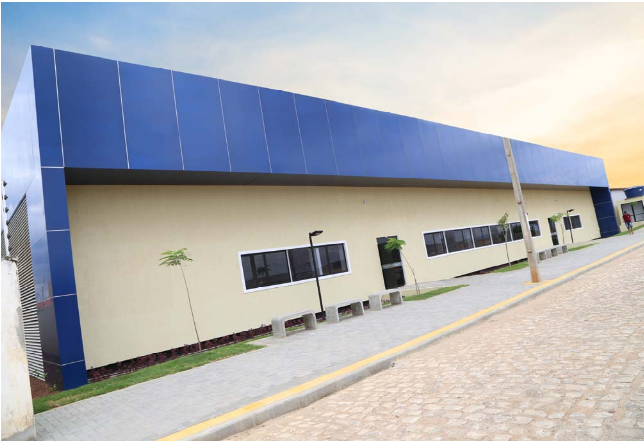
OBRAS DA CENTRAL DO CIDADÃO DE CARAÚBAS
