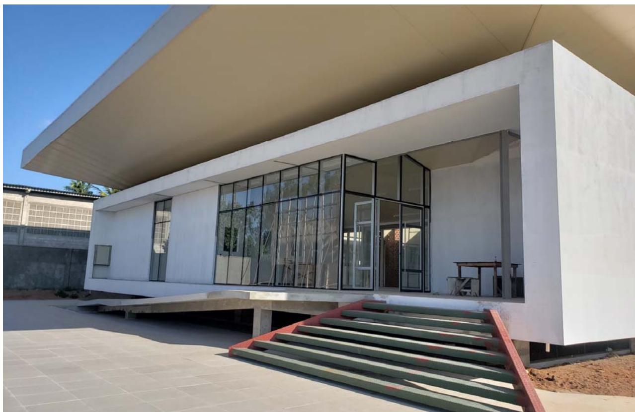
OBRAS DO LABORATÓRIO DE CITOPATOLOGIA
