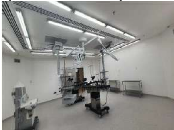
Figura 19 - Conclusão do forro em gesso acartonado
