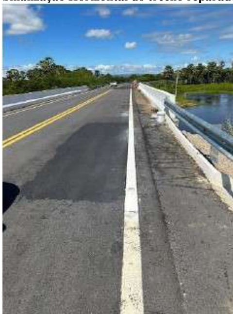
Figura 20 - Sinalização Horizontal do trecho reparado da RN-233
