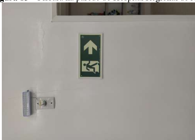
Figura 15 – Fissura na parede do Hospital Regional de Assu
