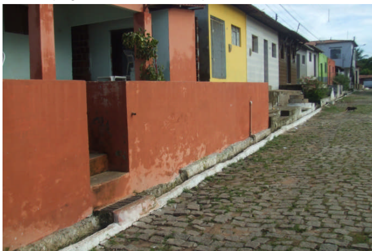
FIGURA 07. Edificações construídas na área do passeio público e desrespeitando a topografia local – Município de Extremoz/RN.
