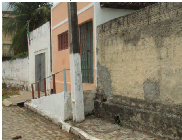
FIGURA 09. Implantação Errada de Equipamento Urbano no Passeio Público São Gonçalo do Amarante/RN.
