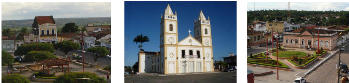
FIGURA 38. Vista dos Casarões e Sobrados (à esquerda), Igreja Matriz (centro) e Grupo Escolar Barão de Mipibu (à direita), entorno da Praça Des. Celso Sales.
