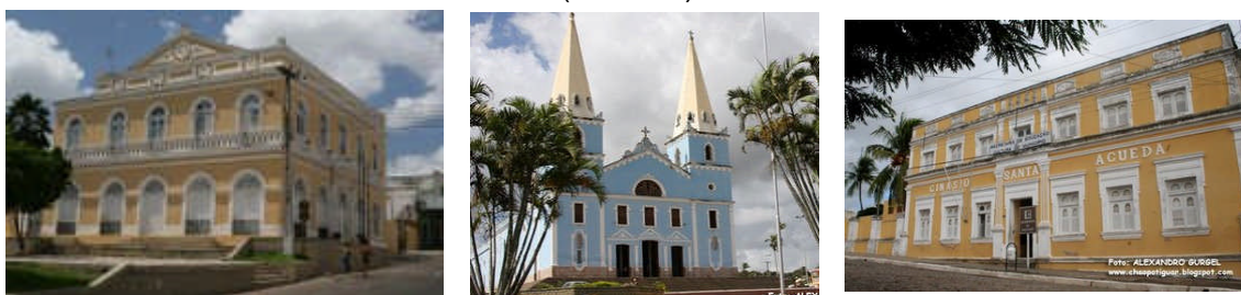
FIGURA 35. Solar dos Antunes (à esquerda), Igreja Matriz (centro) e Ginásio Santa Águeda (à direita).
