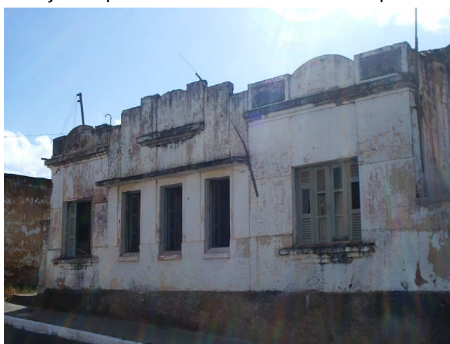
FIGURA 20. Edificação Implantada sem Recuos - Município de Ceará-Mirim/RN.
