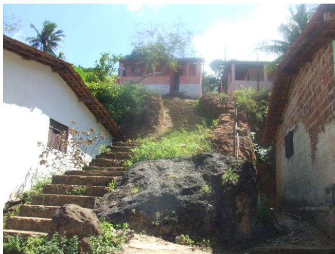
FIGURA 08. Edificações em Área de Alta Declividade com Acesso Precário – Sen. Georgino Avelino/RN.
