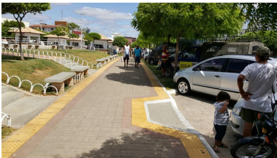
FOTO 28: PISO TÁTIL EM PRAÇA DE PAU DOS FERROS.
