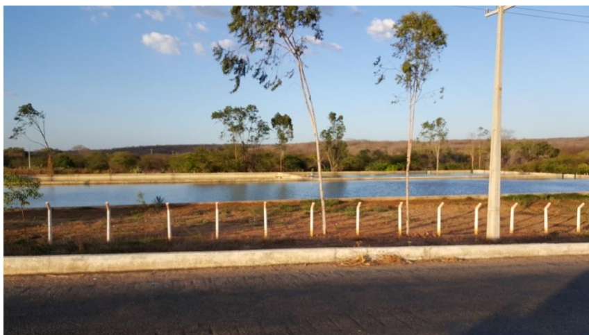
FOTO 32: LAGOA DA ESTAÇÃO DE TRATAMENTO DE ESGOTOS DE RIACHO DA CRUZ.
