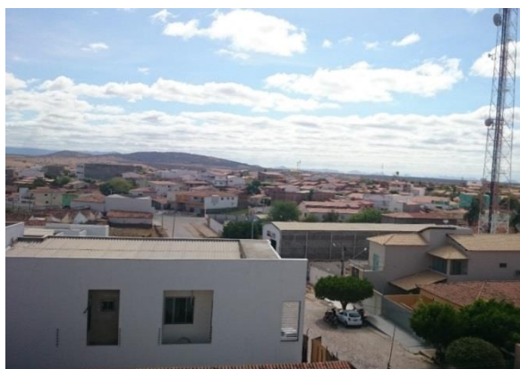
FOTO 39: TORRE DE CAPTAÇÃO E TRANSMISSÃO DE SINAIS - PAU DOS FERROS. Fonte: ITEC, 2015.
