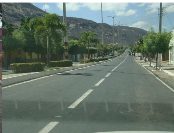
FOTO 36: VIA ASFALTADA EM PATÚ TAMBÉM RESPONSÁVEL PELA COLETA E CONDUÇÃO DAS ÁGUAS PLUVIAIS.
