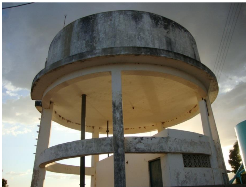
FOTO 29: RESERVATÓRIO DA CAERN - LUCRÉCIA.
