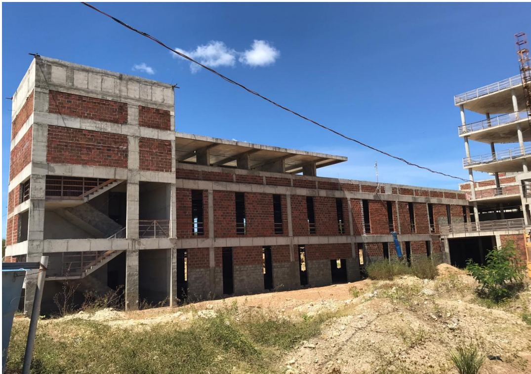
Foto 10 – Fachada do Bloco “B” e “C”
