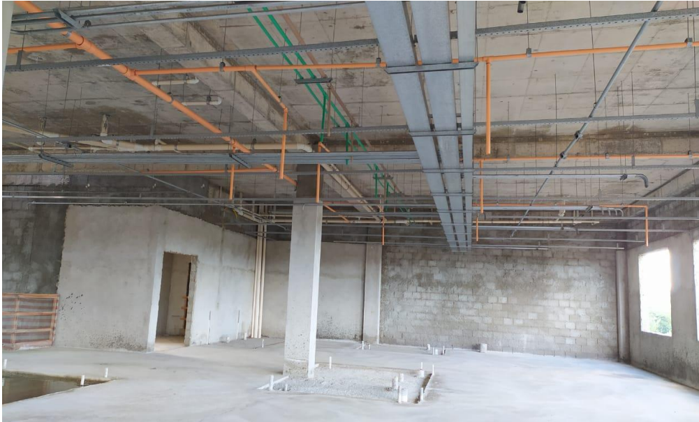
Foto 3 – Bloco A - Alvenaria - Instalações – Contrapiso – Reboco
