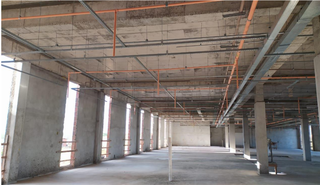
Foto 5 – Bloco A - Alvenaria - Instalações – Contrapiso – Reboco
