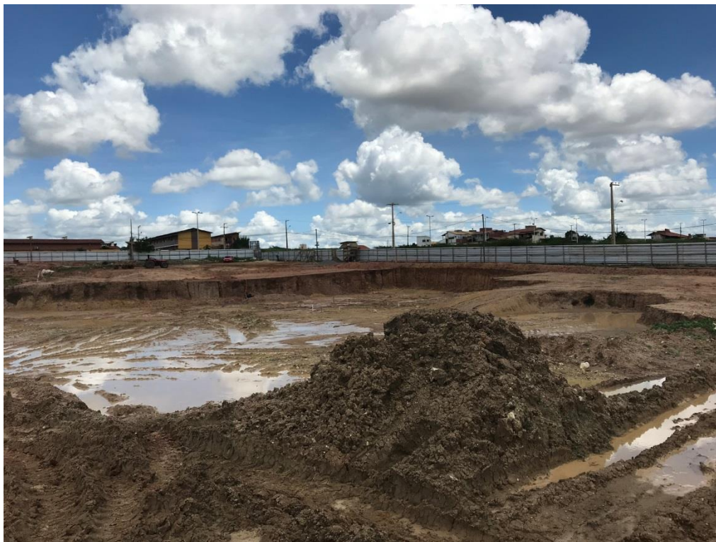
Foto 14 - Serviços de movimento de terra paralisados em função das chuvas.
