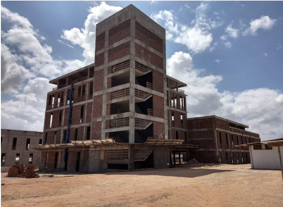
Foto 1 – Fachadas do Bloco “A”, “B” e “C”
