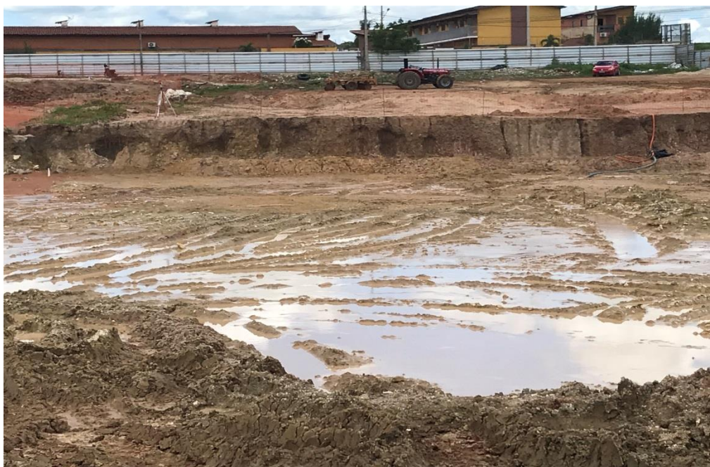
Foto 13 – Serviços de movimento de terra paralisados em função das chuvas.
