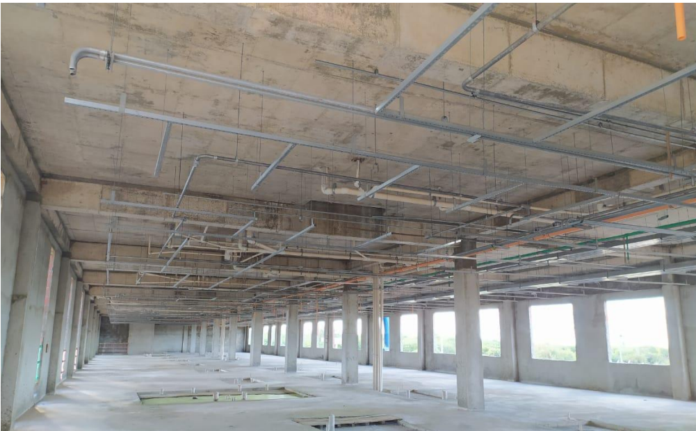
Foto 4 – Bloco A - Alvenaria - Instalações – Contrapiso – Reboco
